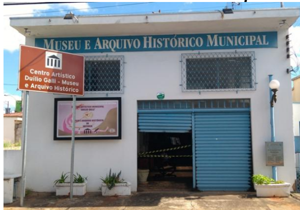
Figura 96- Prédio atual do Museu Municipal “Duílio Galli”
